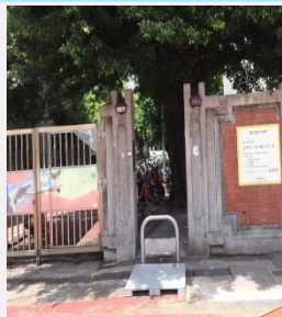
(3)民生校區西側出入口
